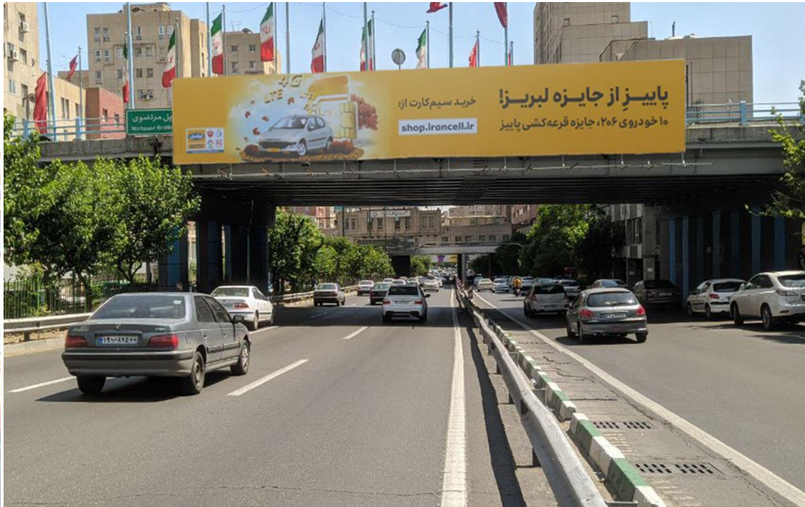
بزرگراه نواب پل سواره رو مرتضوی شمال به جنوب
